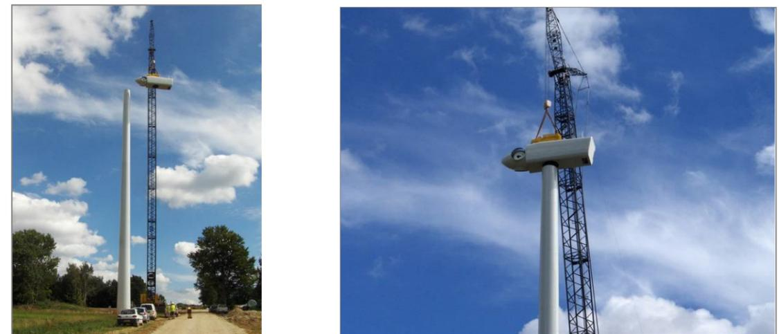
Figure 17 : Photos d'un chantier - assemblage de la nacelle
