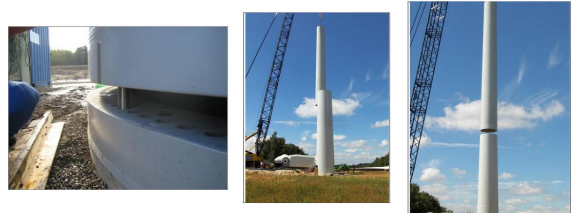
Figure 16 : Photos d'un chantier - assemblage de la tour
